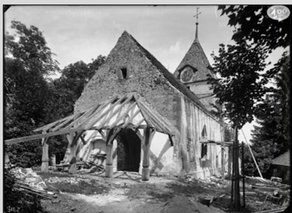
Chantier de restauration du temple de Giez, 1904, photo : Victor Henri Bourgeois.
